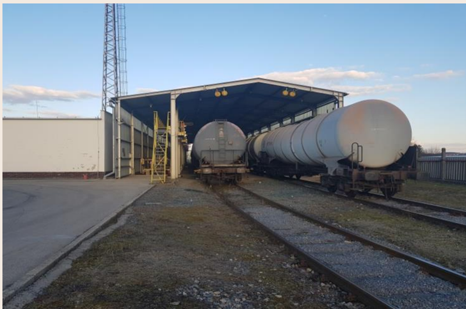
ČEPRO, a.s. Vlečka Střelice-stáčiště železničních cisteren
