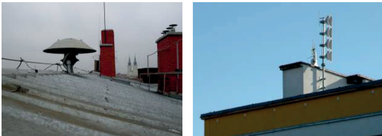
Obr. 26 Rotační a elektronická siréna (vlevo ROT typ DS 977 3,5 kW, vpravo ENS typ MAESTRO 1000W) [zdroj: HZS MSK]
