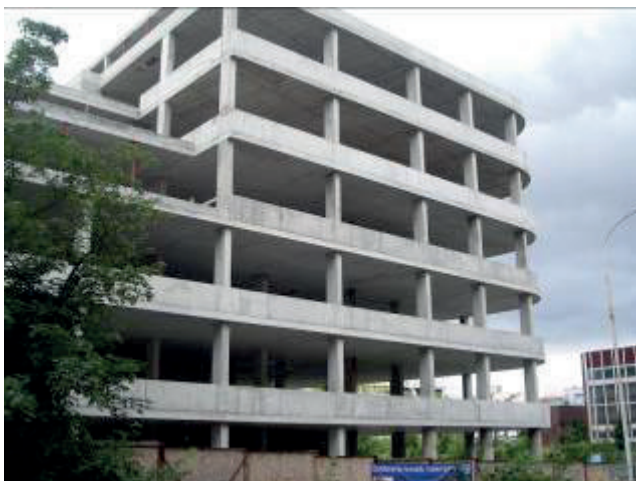
Obr. 6 Objekt se svislými nosnými sloupy
